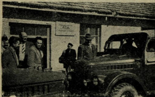
Inž. I. Gotu, načelnik v Direkciji za izgradnjo kanala Donava-Tisa-Donava, odhaja s skupino novinarjev po konferenci na ogled gradbišč.
