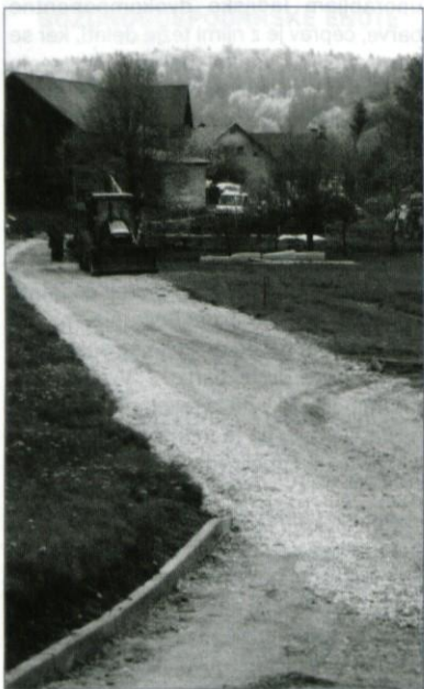
Gradnja ceste in javne razsvetljave.
