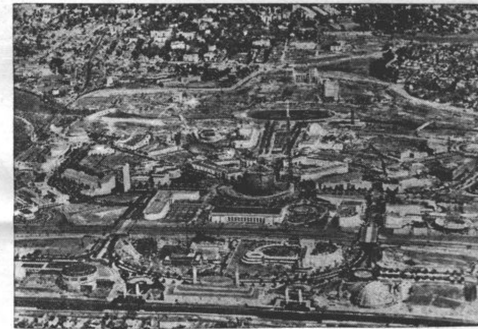
PROSTOR NEWYORSKE SVETOVNE RAZSTAVE. Pogled na velikanski prostor, ki ga bodo zavzemale razstavne zgradbe in kjer pripravljajo ta čas vse potrebno z mrzlično naglico
