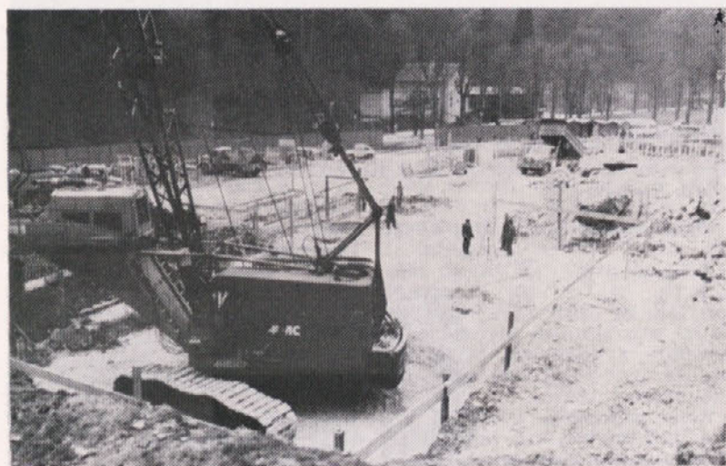
Veliko mehanizacije pri začetnih delih na gradbišču novega hotela na Dobrni
