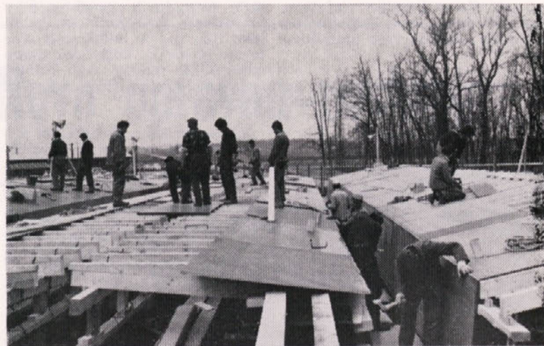
Skupina tesarjev iz TO Lesni obrati z Gomilskega pri montaži opaža mostu
