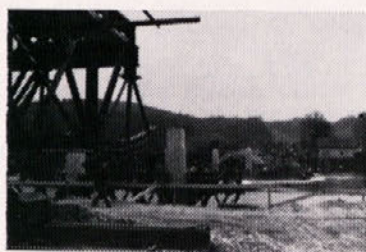
Betonski stebri za novi most že stojijo
