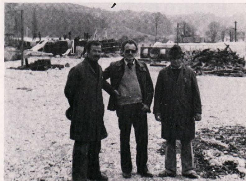
Na gradbišču mostu čez Dravo. Z leve: Karli Rom, delovodja iz TO Mehanizacija, Peter inž. Pavlin, soprojektant in odgovorni vodja del, Florijan Kos, delovodja iz TO Slovenske Konjice.
