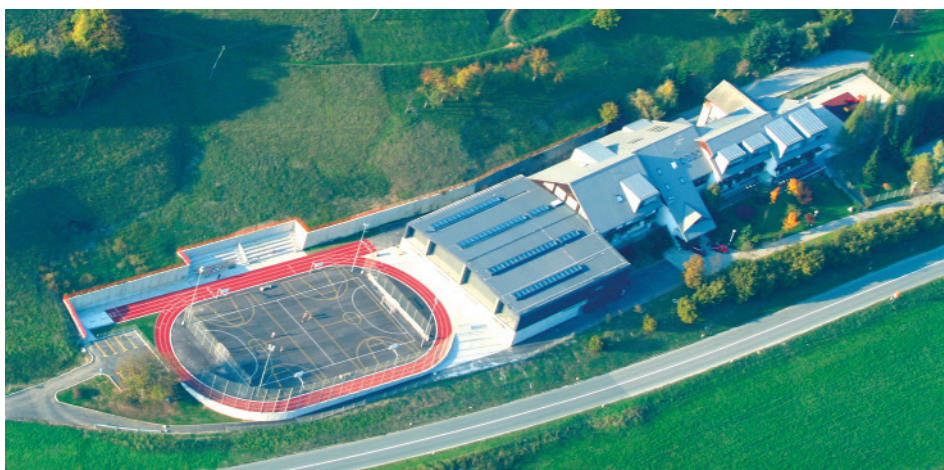
Osnovna šola Poljane z novo telovadnico in zunanji igrišči. (foto: Izidor Jesenko)
