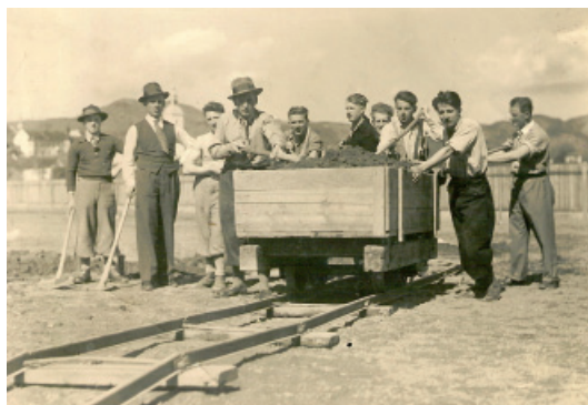
Priložnostni tiri z vagončki za prevoz zemlje in kamenja pri gradnji nogometnega igrišča v Puštalu (po letu 1936).
