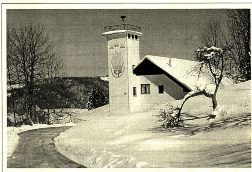
Dolgoletna želja gasilcev PGD Vrh se je uresničila. Asfalt mimo gasilskega doma.
