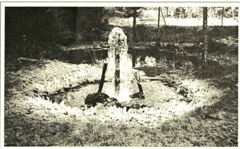
... in našli rešitev za dokončanje problema z vodo (vrtina pod Buhovcem).
