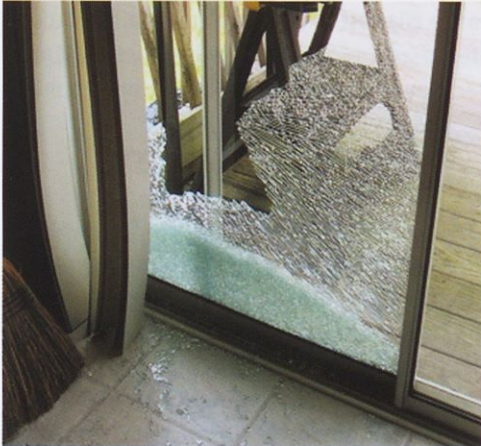
Slika 107: lom kaljenega stekla.
