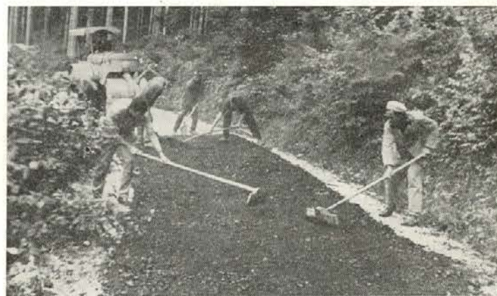
Gozdno gospodarstvo Slovenj Gradec opravlja poizkuse v gradnji utrjenih vozišč. Na sliki poskusno utrjevanje kamionske ceste z asfaltom. (Foto: Dušan Dretnik, dipl. inž. gozd.)
