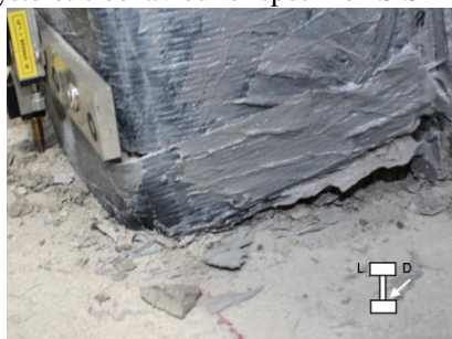
Slika 4.37: Odlepitev plašča ob vpetju Figure 4.37: FRP delamination at the base
