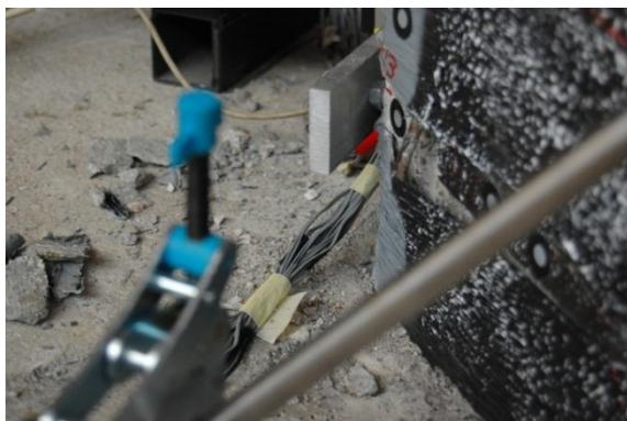
Slika 3.94: Uklon vzdolžne palice – začetek delaminacije ojačitvenega traku (JZ)
