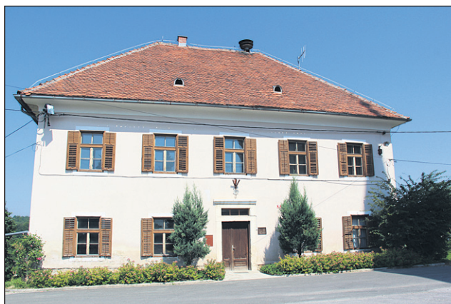
»Vse je uničeno. Spodnja streha je uničena, voda zateka v stavbo,« je o županovem predlogu o obnovi stare šole dejal svetnik Vrbančič in dodal, da bi bilo bolje, če stavbo porušijo in zgradijo novo.
