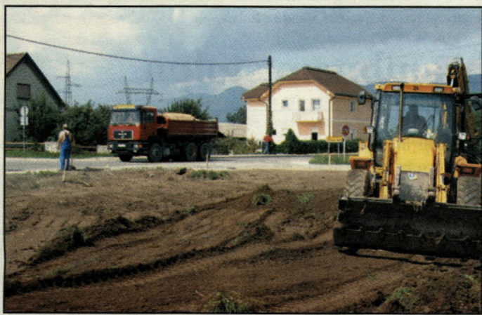
Začetek gradnje krožišča na Bregu pri Polzeli
