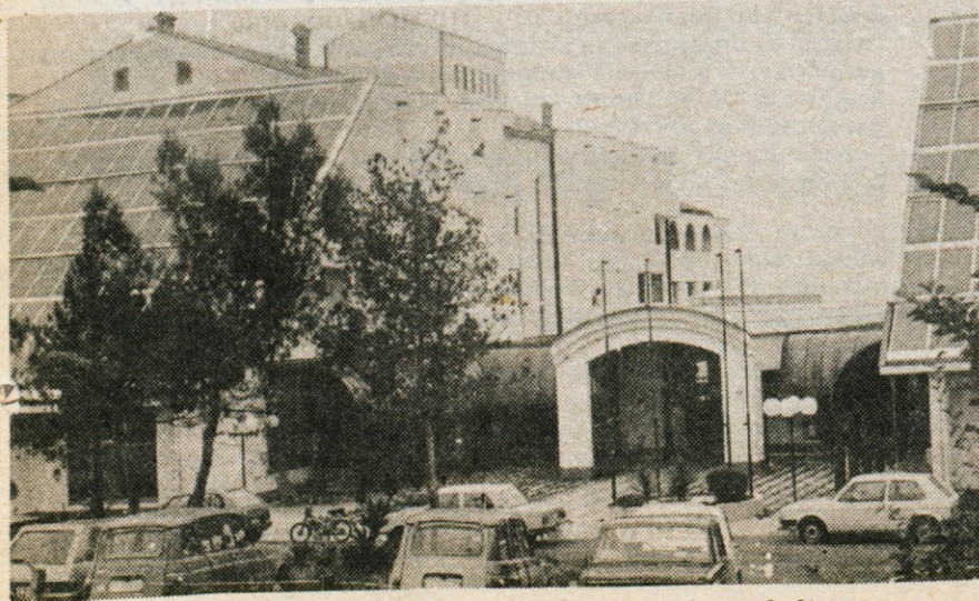
Nova zgradba doma upokojencev v Izoli se lepo staplja z okoljem.
