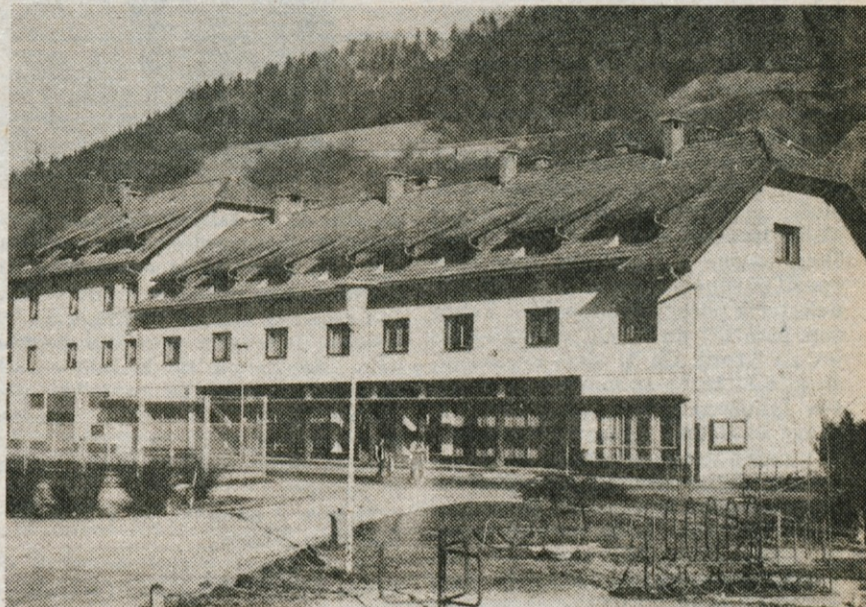
V prenovljeni hiši na Ravnah 9 je stanovanjska skupnost pridobila 23 sodobnih nadomestnih stanovanj, Mercator namesto klasične večje samopostrežno trgovino, člani balinarske sekcije 5. avgust pa klubske prostore.
