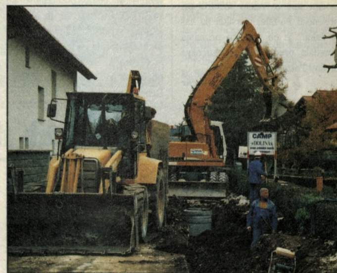
Med izgradnjo kanalizacijskega in vodovodnega voda
