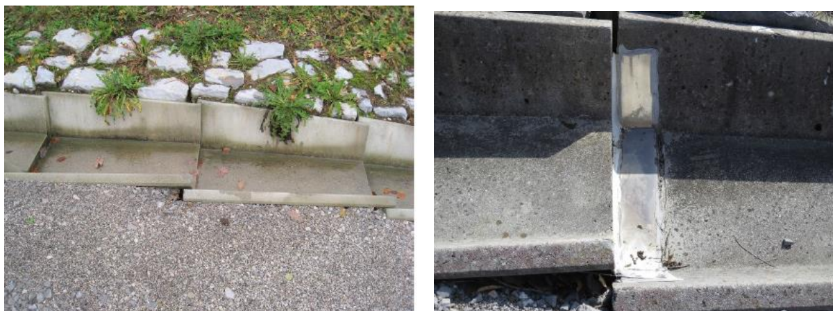
Slika 101: Razmik in premostitev razmika betonskih kanalet (foto: RŽV)
