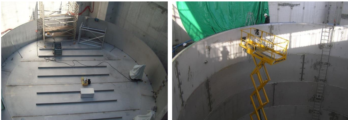
Slika 72: Potek montaže rezervoarja borirane vode za alternativno hlajenje sredice (Foto: inšpekcija URSJV)
