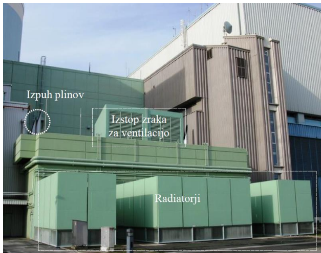
Slika 56: Štirje radiatorji preko katerih se odvaja toplota iz DG1 in DG2
