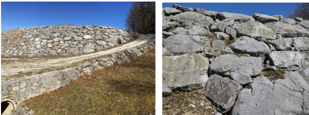
Slika 98: JZ rob odlagališča, spremembe v skalometni peti (foto: RŽV)
