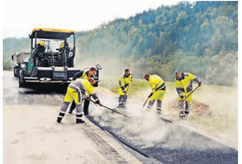
Asfaltiranje razširjene in prenovljene ceste pred Žabjo vasjo
