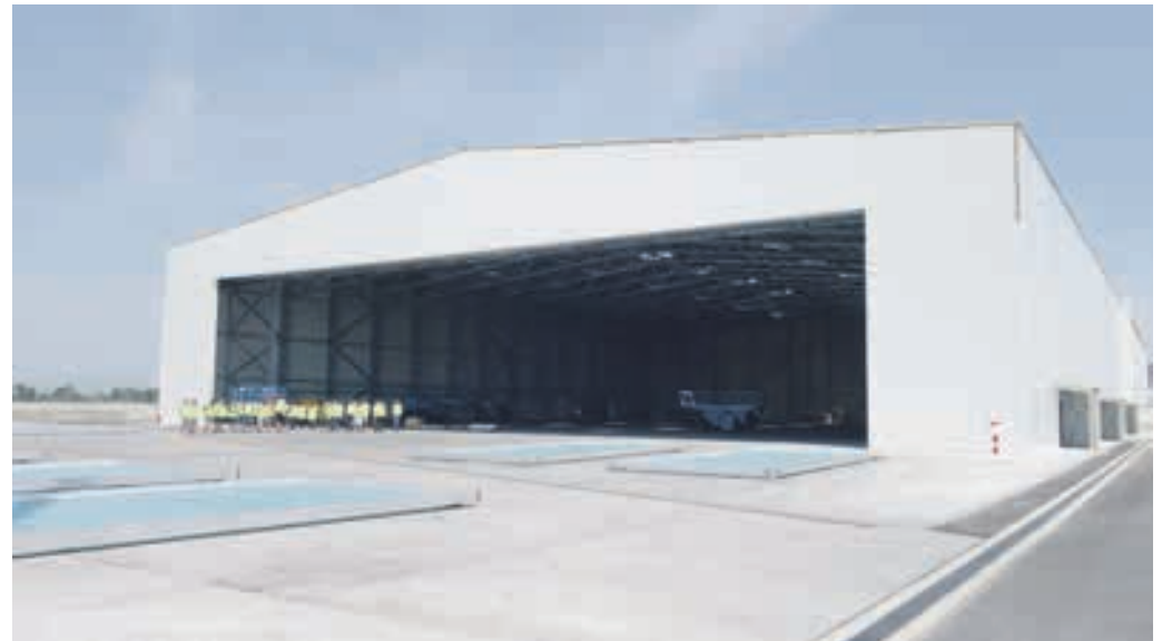
Ekipa podjetja Schwarzmann na ogledu pred zaključkom del pri drugem hangarju.
