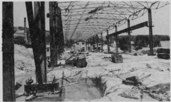
Konstrukcija nove žičarne je že pripravljena.
