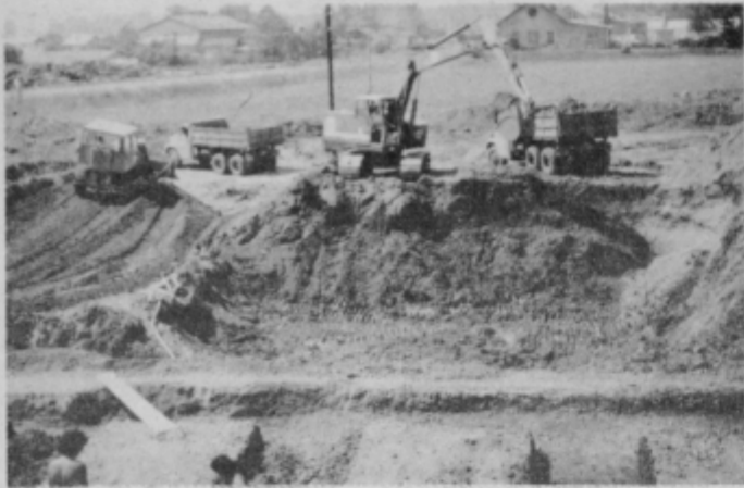
Pogled na gradbišče v katerem se izvajajo intenzivna zemeljska dela za bodoči novi dom gasilcev v Ptuj
