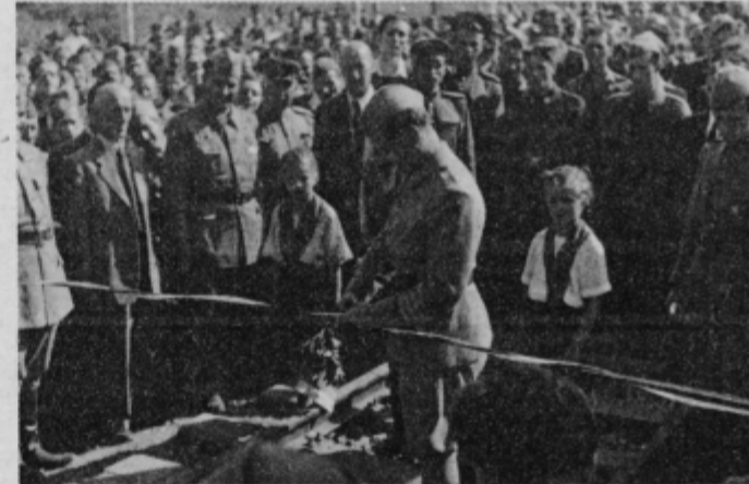
Vojaki prve gradbene brigade VII. korpusa JLA so po osvoboditvi most zgradili v rekordnem času. Vrvico je prerezal general Dušan Kveder-Tomaž.
