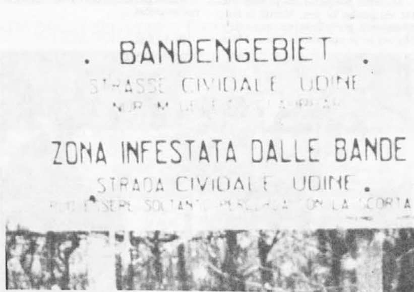
Cartelli stradali bilingui che segnalavano il pericolo partigiano
