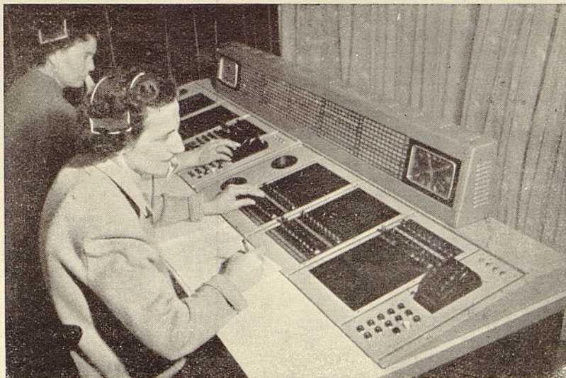
Posredovalna miza v telefonski centrali z vgrajeno konferenčno napravo
