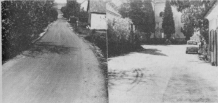
Blato je zamenjala asfaltna plast. Sliki prikazujeta del ceste proti pokopališču in središče vasi. Foto: J. Rakuša
