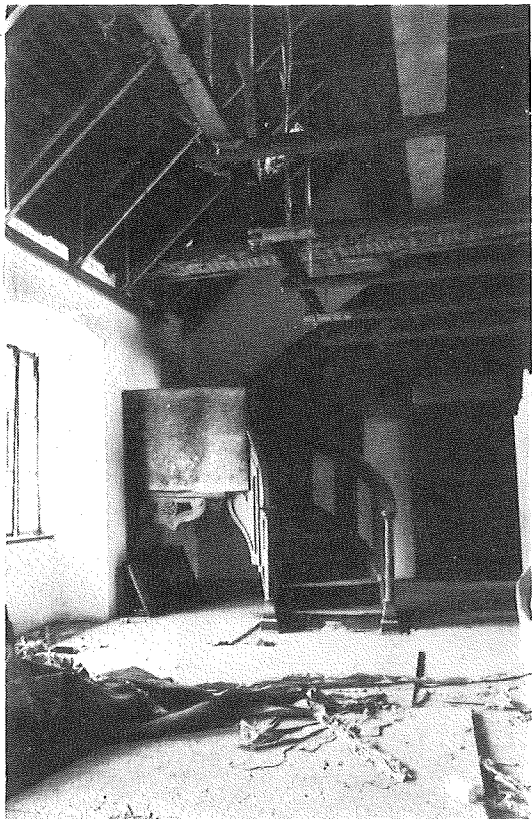
Slika 1: Obnova največjega prostora geodetske zbirke (osrednji prostor)
