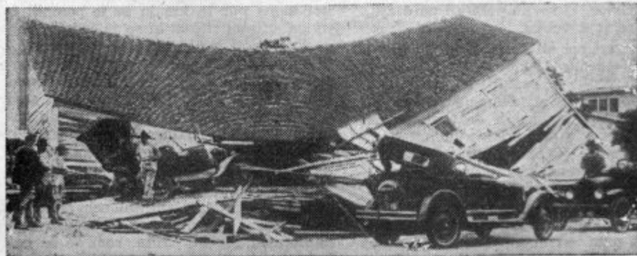
Tornado, ki je divjal v Nebraski, je napravil večmilijonsko znatno škodo in poškodoval prebivališča
