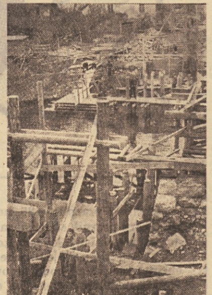
Gradnja mostu v Primostku, na cesti, ki bo povezala Metliko preko Črnomlja z Vinico
