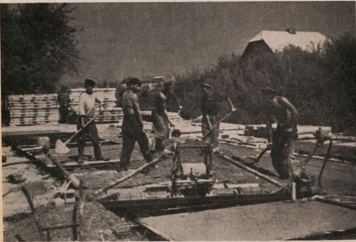
Stropne in stenske armirane plošče se platonirajo na betonski pisti. Delo je enostavno, zahtevna je le preciznost pri armaturi, vibriranju in različnih vrstah
