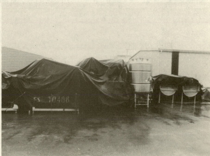
Precej opreme za novo sintezo že čaka na montažo...
