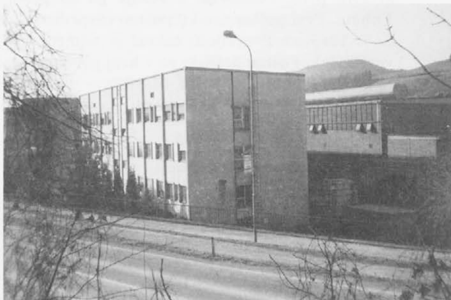
Takšna pa je stavba kemijskega laboratorija danes.
