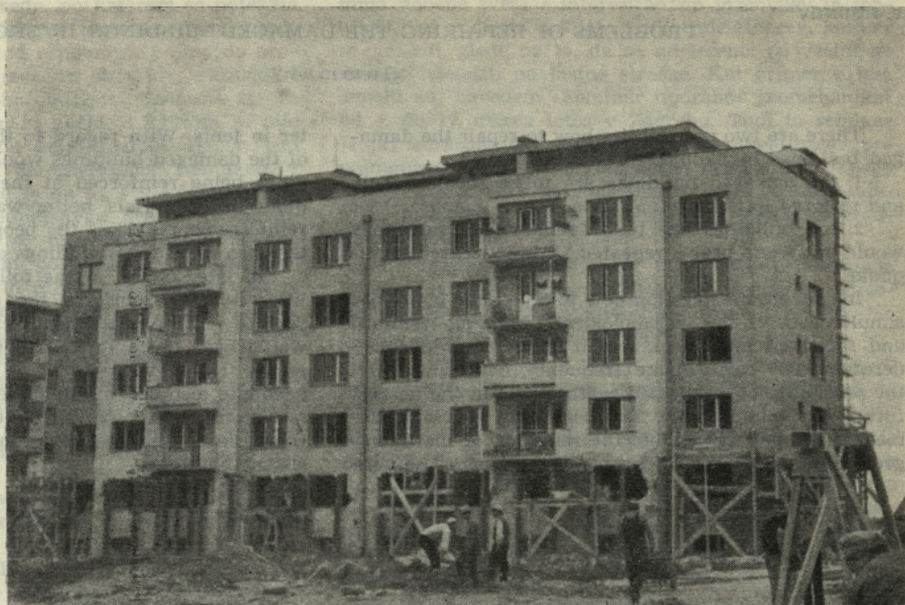
Obnova pritličja stanovanjskega bloka
