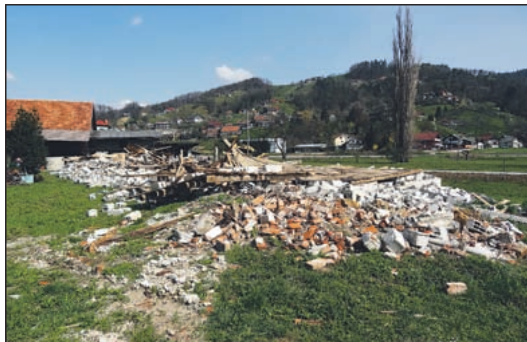
Na zemljišču je še pred dobrimi 14 dnevi stal 30 x 12 metrov velik objekt z urejeno elektriko, vodo, ogrevanjem, prezračevalno napravo ..., danes je kup ruševin.
