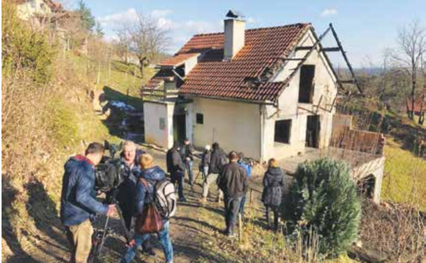
Dan po požaru
