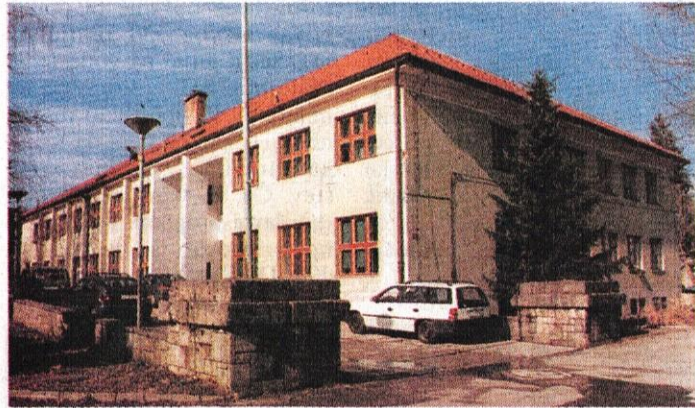
Zgradba kamniškega Kina Dom bo prihodnje leto praznovala 50-letnico. Zato ni čudno, da jo je čas že krepko načel. Po obnovljeni strehi čaka na obnovo še fasada, a bo morala še nekaj časa počakati.
