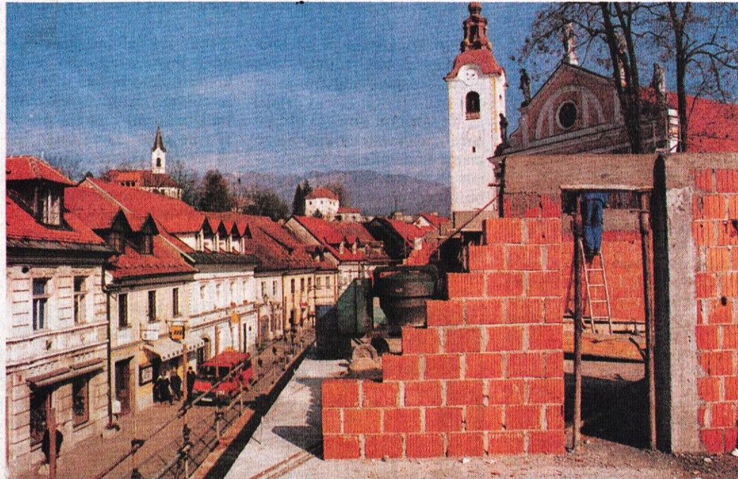
Te dni so delavci Graditelja končali podstrešne zidove in postavili novo streho.
