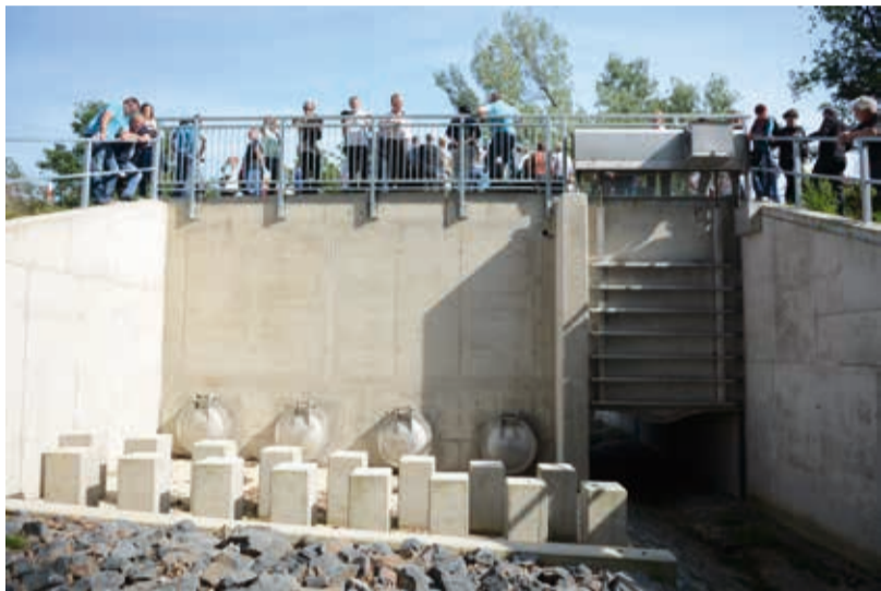
S pomočjo evropskih sredstev zgrajen sistem varovanja pred poplavami
