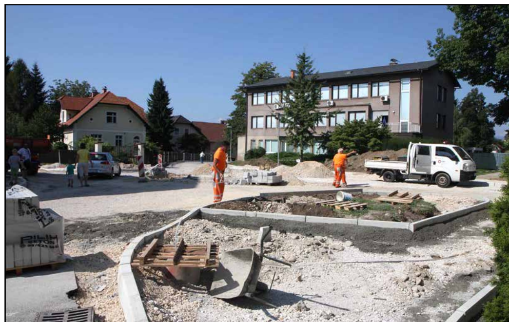
Gradnja mini urbanega krožišča v
