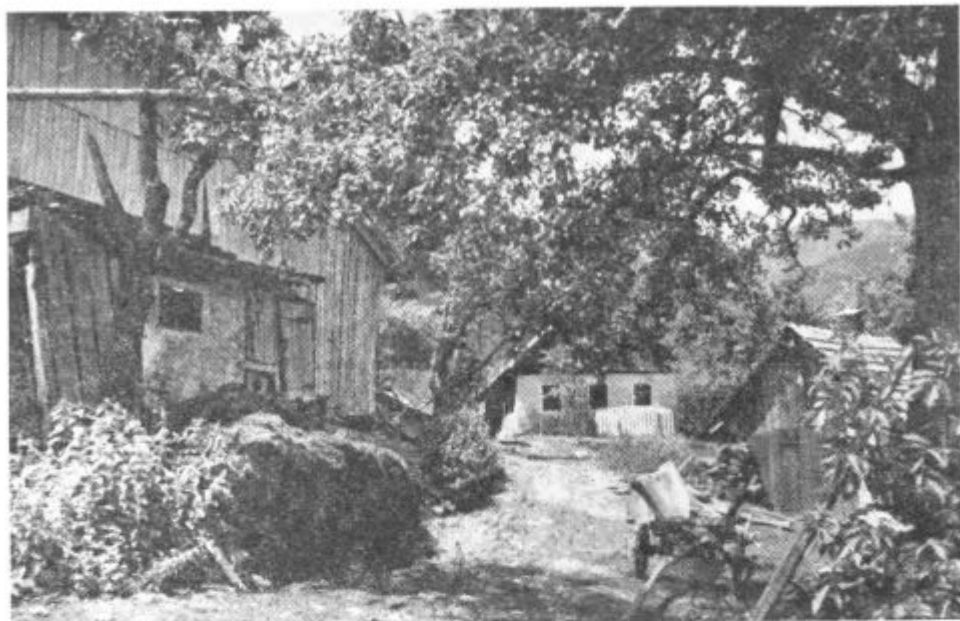
Strajkarjeva domačija in pogled na glavno prometnico v zaselku
