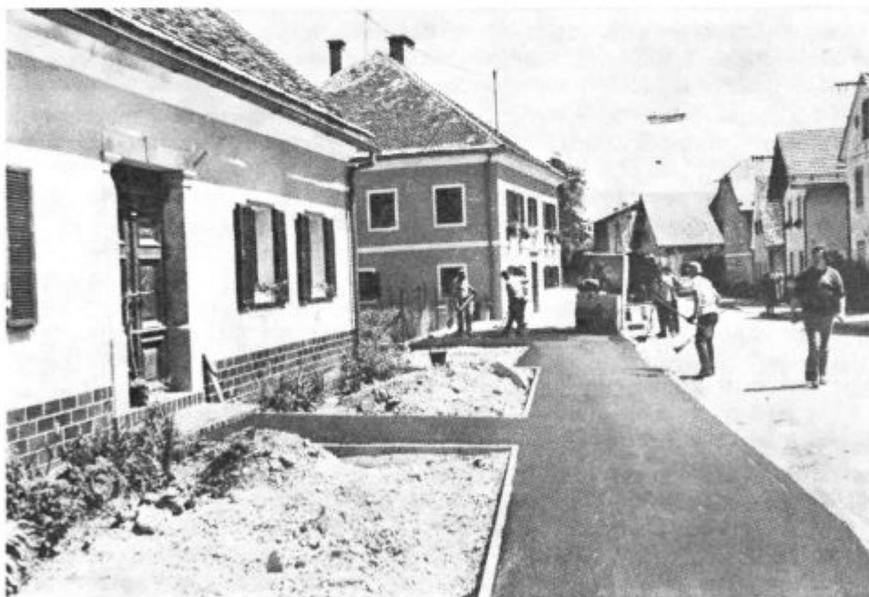
Dela pri obnovi trga Vransko
