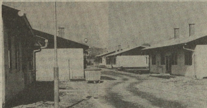
V naselju Nizkih gradenj na Pobrežju je asfalt sedaj že položen, tako da že izgleda lepše, kot na fotografiji.
