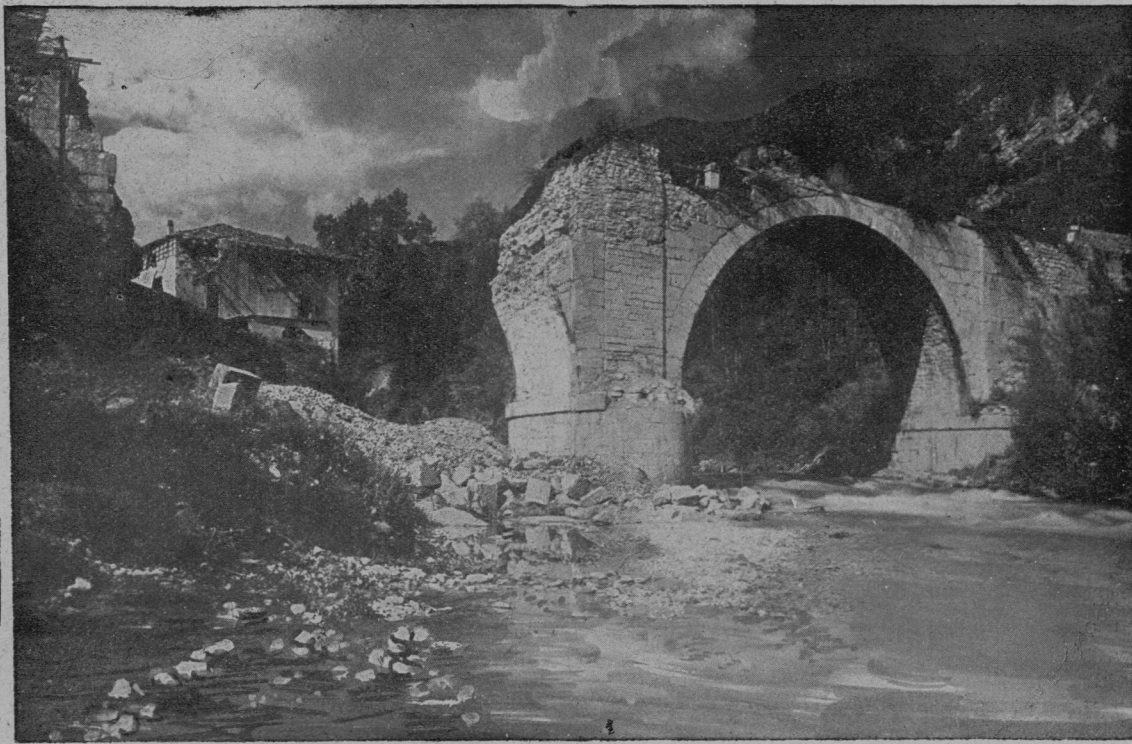
K 11. laški ofenzivi: Porušeni most čez Sočo pri Tolminu.
