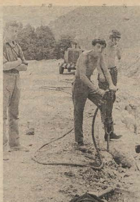
Komaj zgrajeni most pri modernizaciji ceste Impoljca-Pijavsko je na eni strani „počepnil“ pod buldožerjem. V petek so ta del podirali. Dela izvaja novomeško Cestno podjetje. Na sliki: eden vrta, dva gledata. Kdaj bo na ta način kaj narejenega? — (Foto: A. Železnik)
