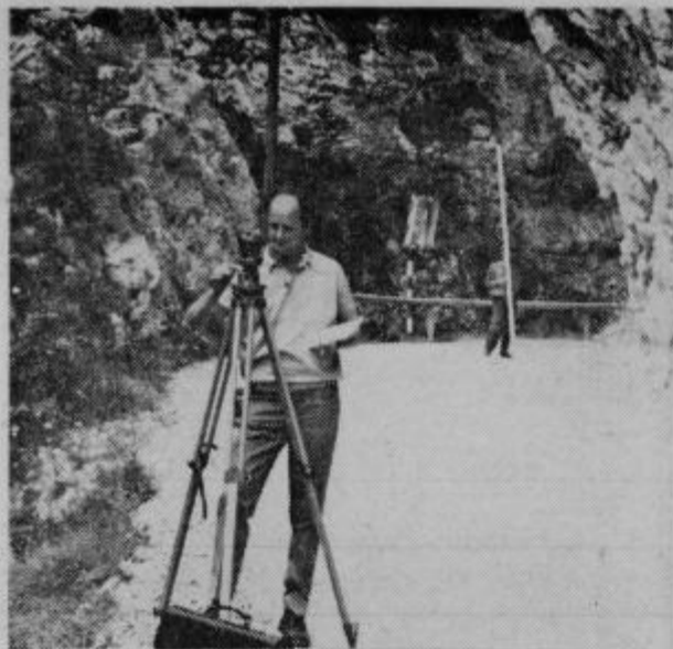
Minuli teden so pričeli s pripravljalnimi deli za asfaltiranje ceste od Igle do Solčave. Na sliki je geometer FRANŽ KRECIC, ki pripravlja situacijo, na osnovi katere bodo izdelali dokončne projekte. Zemeljska dela naj bi opravili letos, asfalt pa bodo položili prihodnjo pomlad. (foto: B. S.)
