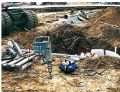
Slika 1: Primer okolja z visokimi tveganji: vlažne razmere, delo na prostem, uporaba prenosne električne opreme (Vir: www.kopp-ag.de )
