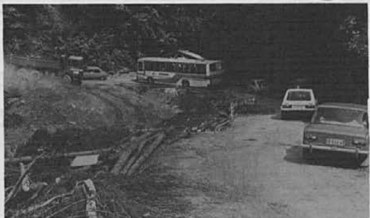
Zgornji del Poljanske doline je z gradnjo ceste Žiri-Trebjars res pravo gradbišče Neprijetno tako za graditelje kot uporabnike ceste
