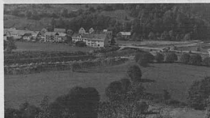
Še pogled na predel, kjer trenutno tečejo dela pri regulaciji Sore
