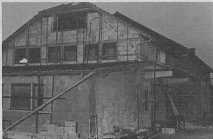
Prizidek ob kulturnem domu v Šentjoštu, v katerem bo obrat Alpine
