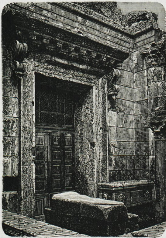
Taufkapelle (battistero) beim Dome in Spalato.
