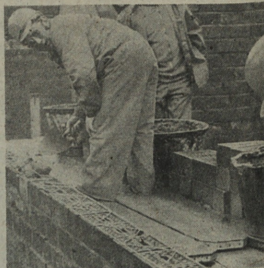
Vstavljanje jeklenih armaturnih elementov v fugo zidu
