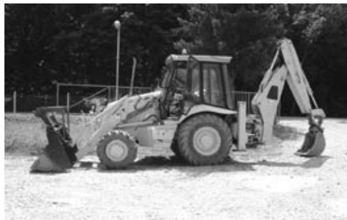
Z bagerjem so na režijskem obratu pričeli izvajati prve izkope
