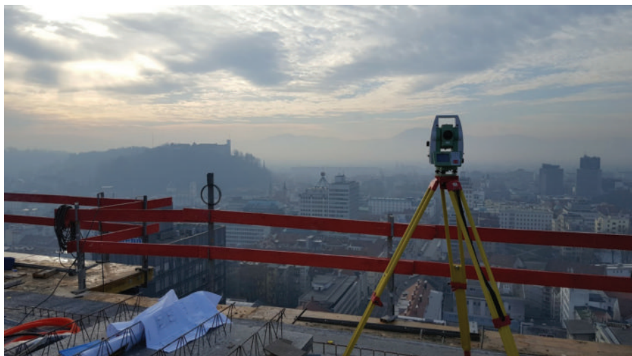
Slika 31: Geodetska spremljava gradnje.
