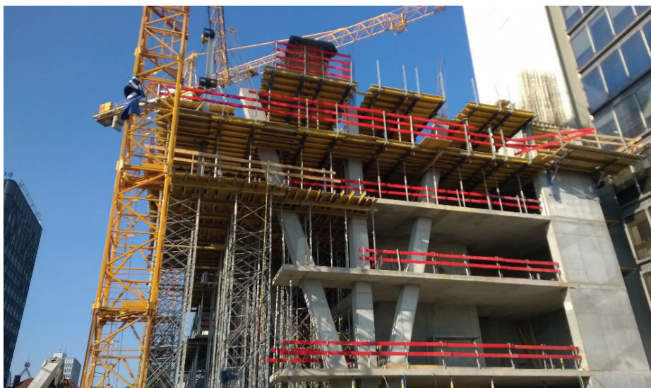
Slika 20: Izvedeni poševni armiranobetonski stebri, vstavljanje opažnih miz tipa Dokamatic.
