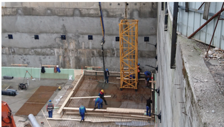
Slika 10: Izvedba temelja žerjava – sidranje v armiranobetonsko temeljno ploščo.
