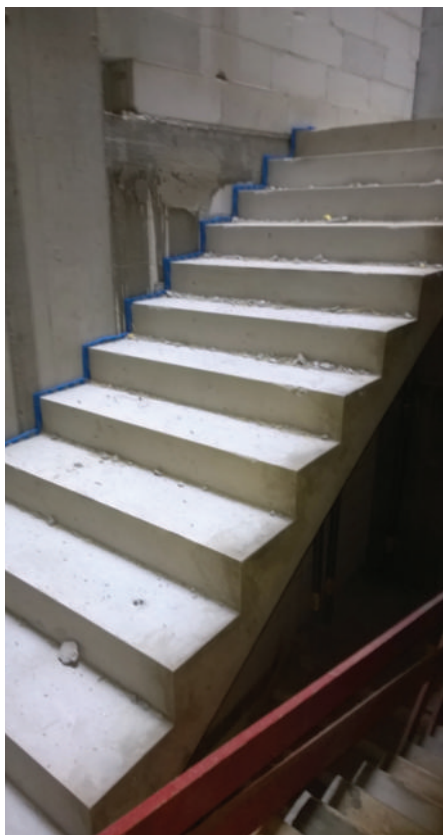
Slika 30: Vgrajene montažne armiranobetonske stopnice.
