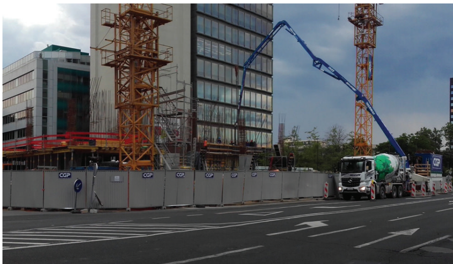
Slika 12: Betoniranje plošče nad pritličjem.
