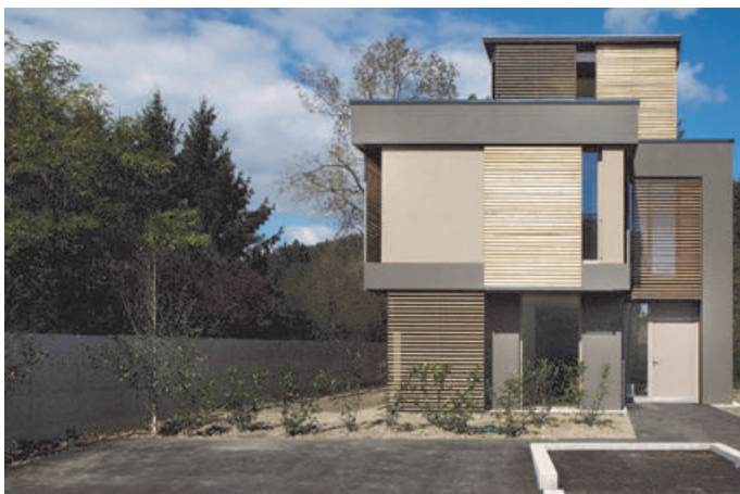
Slika 4: Prvi zgrajeni objekt (enodružinska hiša) na seizmični blazini v svetu.
