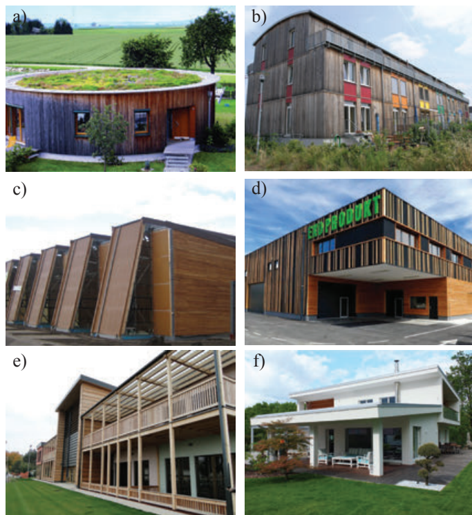
Slika 5: Različni tipi pasivnih hiš: a) Enodružinska pasivna hiša; b) Večnadstropna pasivna hiša; c) Industrijski objekt. Pasivne hiše v Sloveniji: d) Poslovna zgradba (Ekoprodukt d.o.o.); e) Vrtec (Jelovica d.d.); f) Enodružinska hiša (Marles hiše Maribor d.o.o.).
