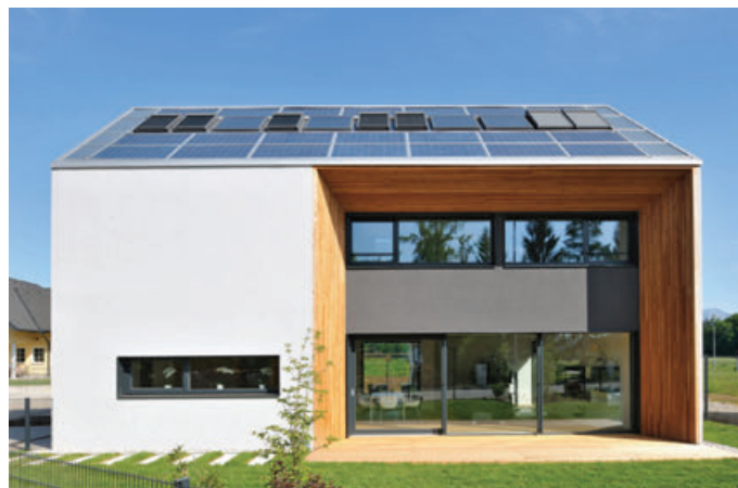
Slika 7: Hiša je v celoti zgrajena iz okolju prijaznih materialov, ki imajo največji vpliva na okolje v fazi izdelave. Hiša vključuje fotovoltaično elektrarno, sončne kolektorje za toplo vodo, strešna okna, zbiralnik deževnice za sanitarno vodo in zalivanje, ter pametne inštalacije.
