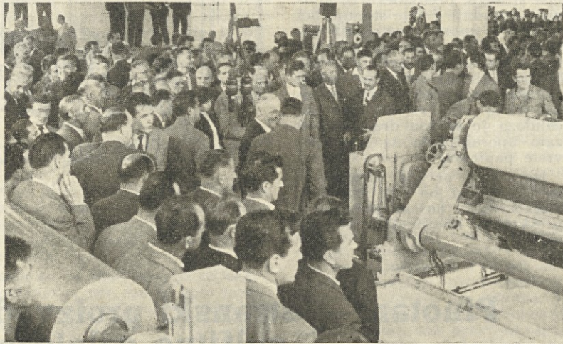
4. julij 1960. »Parada« svečane otvoritve obratovanja. Trenutek simboličnega zagona in papirna masa je pritekla na sito. Preko izžemalne in sušilne skupine so prišli na navijalni aparat prvi kilogrami papirja — plačilo vložnega truda — novi ponos našega delovnega kolektiva
