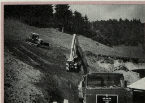
Pričetek sanacijskih del
