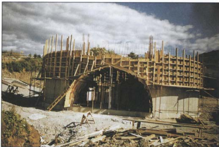
Temelj za posmrtno ostanke Foto Janez Lampret
