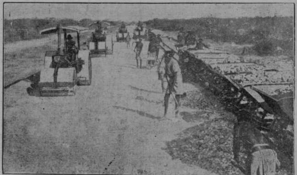
Italijani gradijo in valjajo z motornimi valjarji nove ceste v zasedenem abesinskem ozemlju.
