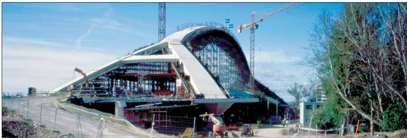
Slika 1. Železobetonski most tisočletja v Zaragozi – l = 270 m, h = 36 m
