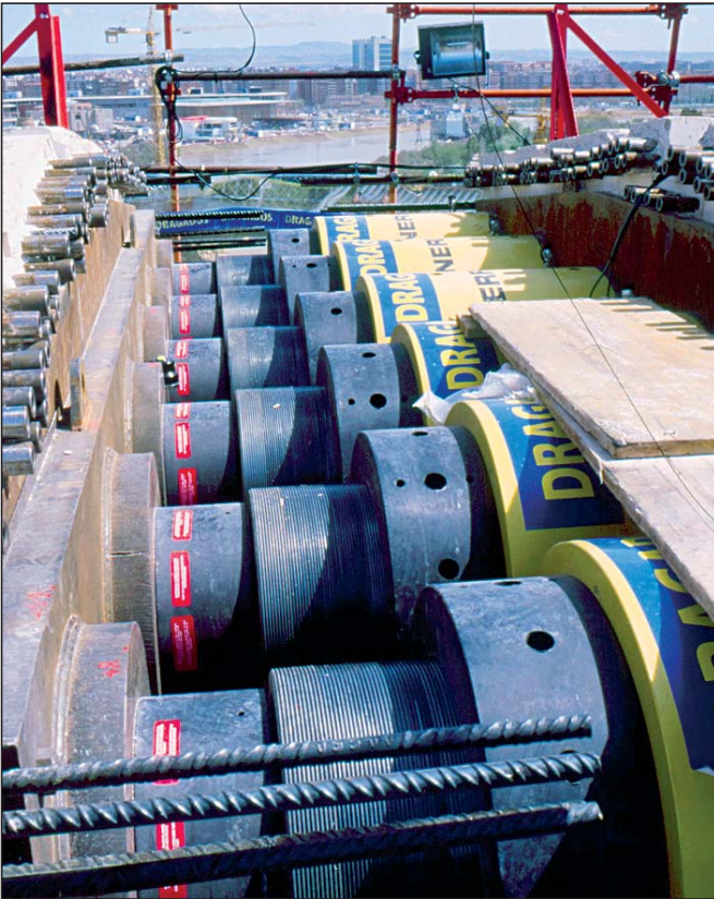
Slika 2. Hidravlični valji (3 pari) z varovalno matico in posamično imensko silo 2000 t za razmikanje dveh polovic loka, krmiljeni s skupnim programskim sinhronim krmilnikom
