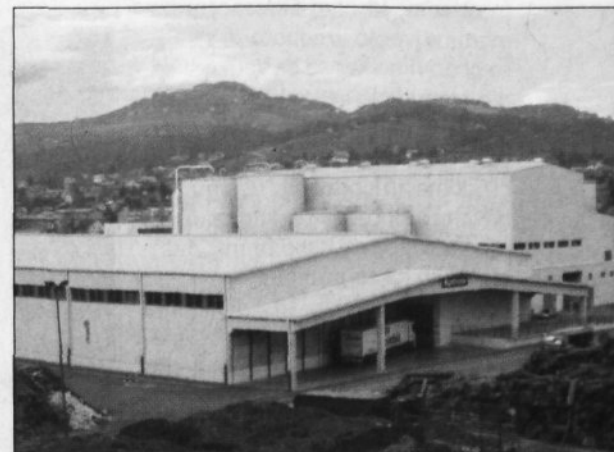
Nov objekt za predelavo odpadnega papirja
