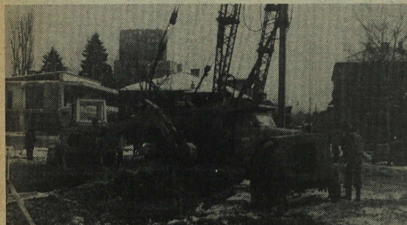
Delo na podvozu Erjavčeve ceste v Ljubljani
