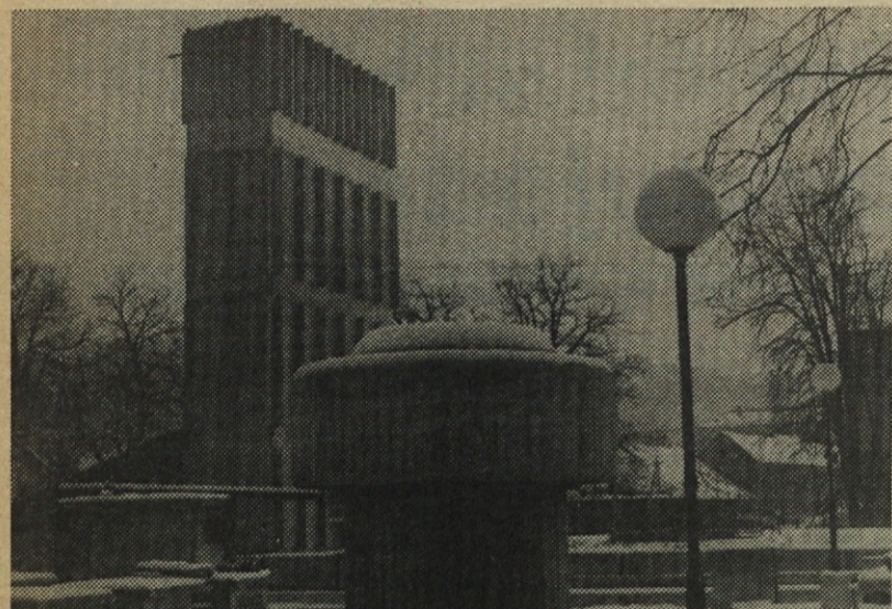
Jašek za zajem zraka in 13 m visoka zračna montažna odprtina sta edina objekta Onkološkega inštituta I. faze, ki se dvigujeta nad nivojem terena. Vsi ostali objekti so 8 m pod zemljo
